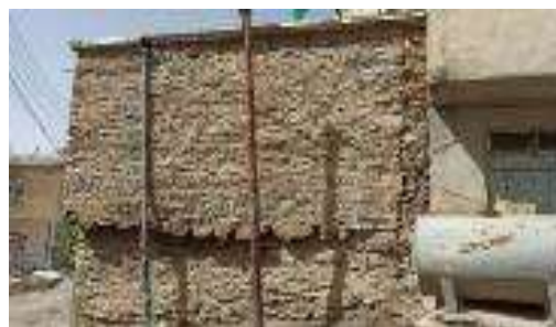
شکل ۹. ساخت رخیام در طبقات با استفاده از تیرهای فرعی در خانه‌های بومی پاهو
