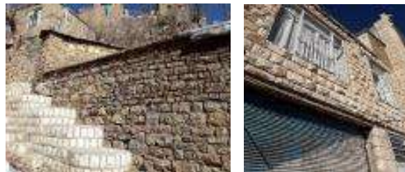
شکل ۷. ساخت رخیام با استفاده سنگ تخته‌ای در خانه‌های بومی پاهو
