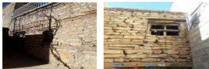
شکل ۸. ساخت رخیام با استفاده از تیرهای فرعی دیوار در خانه‌های بومی پاهو
